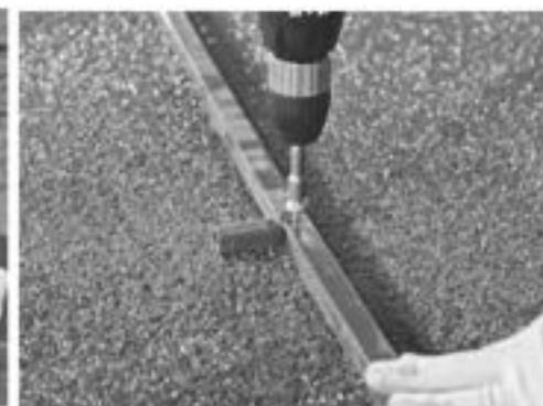
Затем необходимо собрать торцы и дуги. Все части соединяются при помощи надежно вваренной профильной трубы  $15*15$  по принципу «папа-мама» и крепятся кровельными саморезами  $5,5*19$ . После соединения, дуга приобретает дополнительную жесткость за счет эффекта «труба в трубе».
