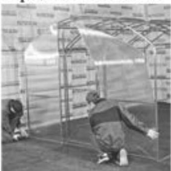
Затем производится монтаж вырезанных панелей дверей ( либо монтируются заготовки 2,1\*1м, а потом вырезаются по верхнему контуру каркаса теплицы, и отрезается с одной из боковых сторон, то есть «по месту»). Далее на дверь устанавливается форточка и ручка с заверткой с помощью саморезов 3,9\*19. В верхней части двери поликарбонат крепится только к каркасу форточки.
