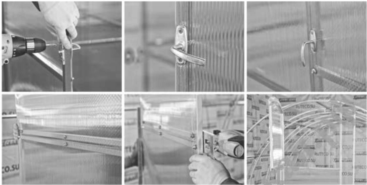
Затем листы поликарбоната 6,0\*2,1м монтируются на боковые стенки и дугу без разрезания. Листы пристыковке укладываются друг на друга в нахлест 10-15см. Крепить листы необходимо к каждой стойке, через 50-70см, а также по периметру верхней боковой перемычки.
