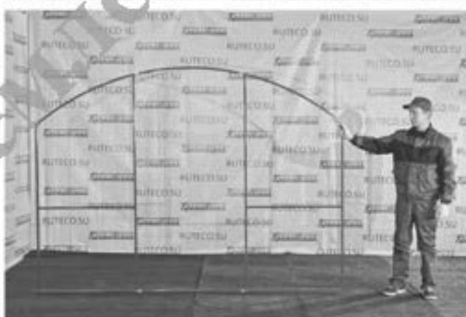
Далее необходимо установить торцы и дуги на «принимающие» основания. После чего прикрепить к ним установленные на направляющие конструкции кровельными саморезами 5,5\*19.
